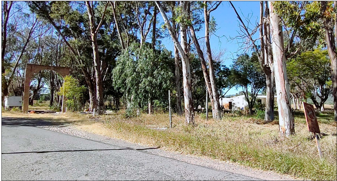
Figura 2. Infraestructura avícola abandonada, se observa una caseta con la leyenda “Almacén de Medicamentos” y la entrada con un letrero de Pilgrim’s. Fuente: fotografía tomada en noviembre de 2022.
