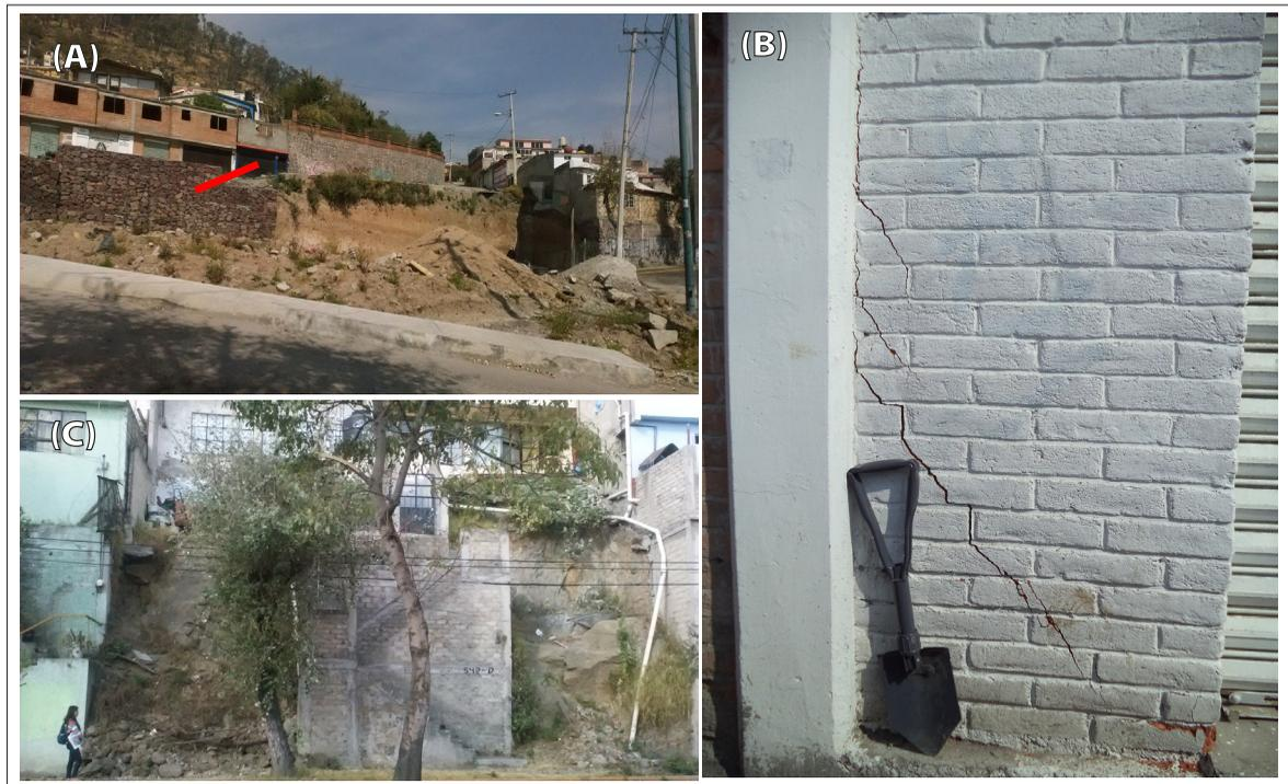
Figura 8. A: nivelación del terreno para la construcción de una obra en una zona de pendientes superiores a los  $15^\circ$ . Se indica con una flecha roja la aplicación de una medida estructural “Muros de gaviones” para evitar la ocurrencia de movimientos de ladera. B: grietas en paredes en construcciones adyacentes. C: desprendimientos de rocas que debilitan el sustento de viviendas, provocando el socavamiento de sus cimientos.
