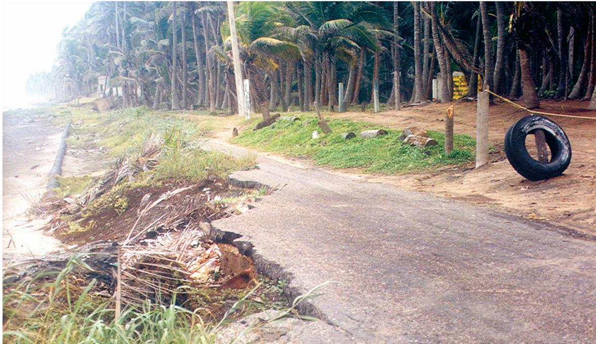
Figura 6. Ruptura de la carretera costera como resultado del retroceso de la costa, en el poblado El Alacrán (hoja E15A78, Cocohital), en el estado de Tabasco (septiembre de 2004).
