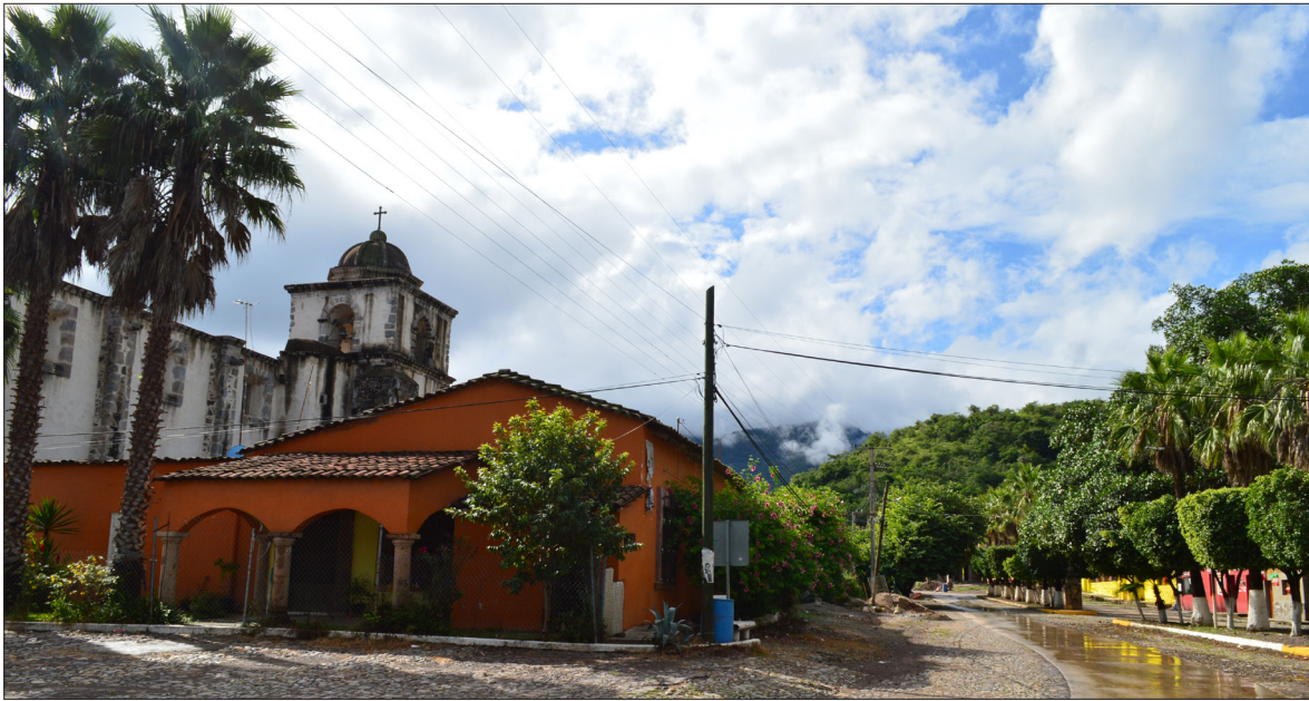
Figura 1. Capilla y tienda de raya, edificio reconstruido, de la ex hacienda de Ayacapán en el valle de Autlán-El Grullo, seleccionado por su topografía: varias elevaciones, Sierra de Cacoma y Sierra de Manantlán al norte, oeste y sur, además del cerro Las Joyas de los Zapotes. Se aprecia también un arroyo que sólo en temporada de lluvia muestra alguna corriente. Archivo de campo, 23 de septiembre de 2017.
