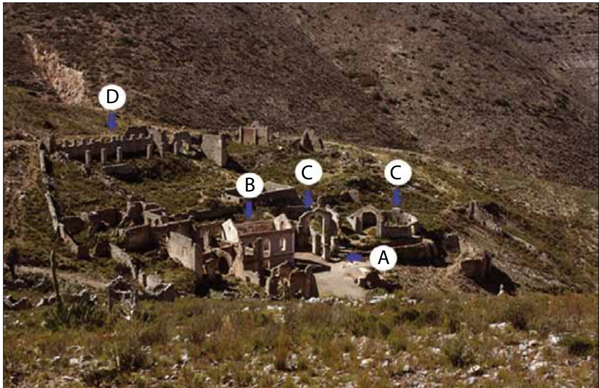
Figura 7. Minas de La Concepción. A. Tiro de las minas; B. edificio en que se encontraba el malacate; C. molinos; D. lo que pudo ser un establo. Autor: Gerónimo Barrera, archivo de campo, diciembre 2010.
